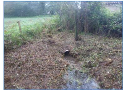
*Sortie de la buse alimentée par l'écoulement du réservoir*
